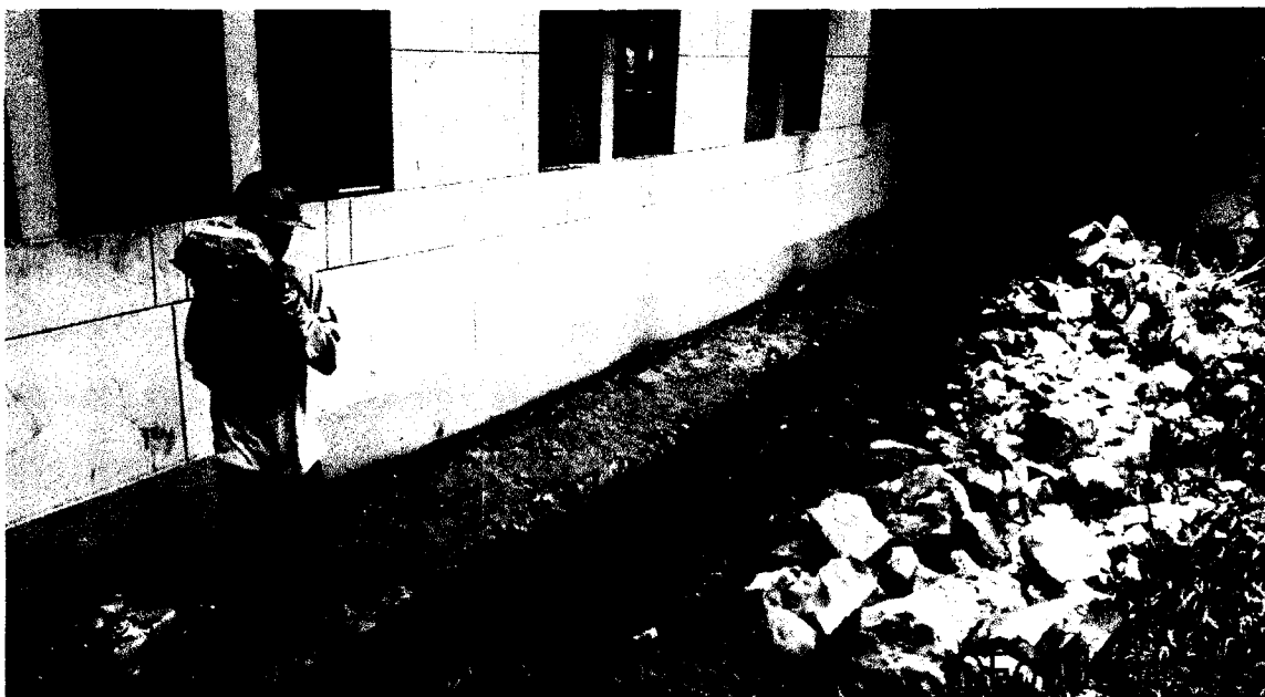
Vista de demolición de vereda.
